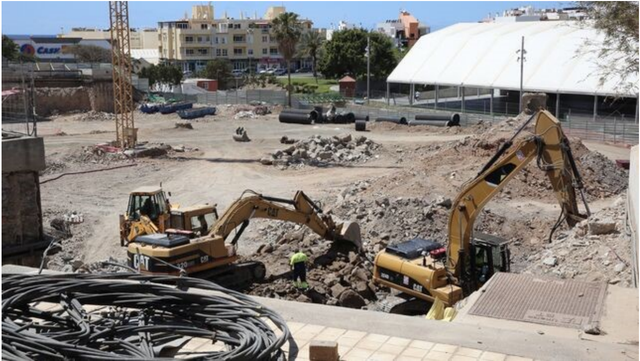
Imagen de archivo, obras en el nuevo aparcamiento de Arguineguín. ALEJANDRO RAMOS
