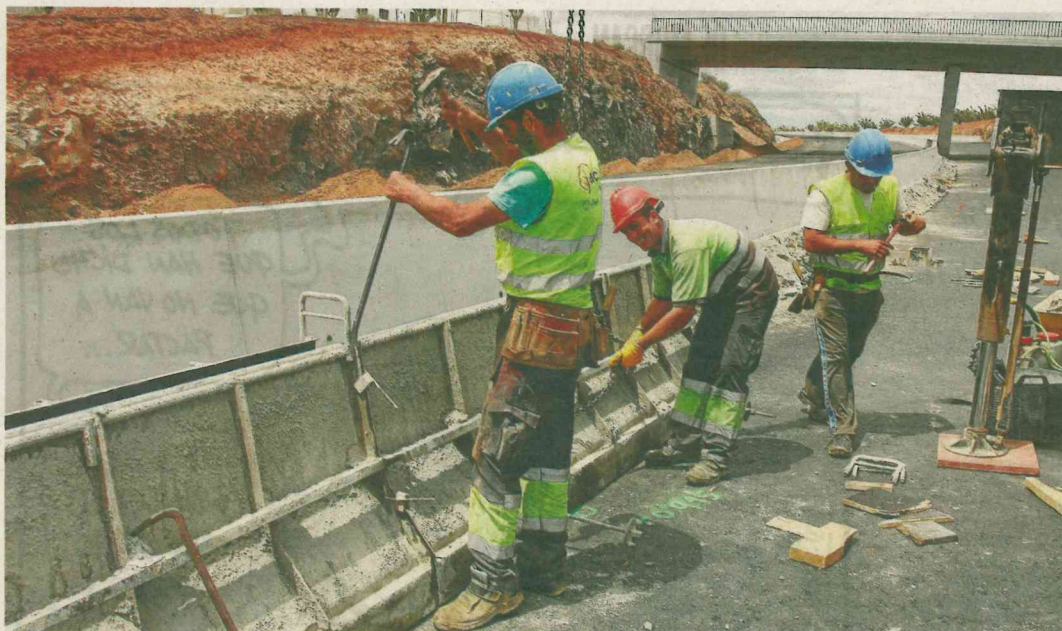
Imagen de trabajadores en una obra en la isla de Lanzarote. Los cabildos y ayuntamientos han reducido sus inversiones públicas en este 2019.
