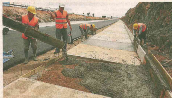
Imagen de archivo de operarios trabajando en una carretera.
