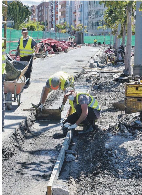
Obras de la metroguagua en la calle Venegas. | ANDRÉS CRUZ
