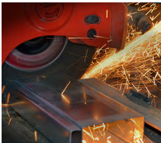
Ruido generado por el uso de maquinaria pesada y equipos de corte.
