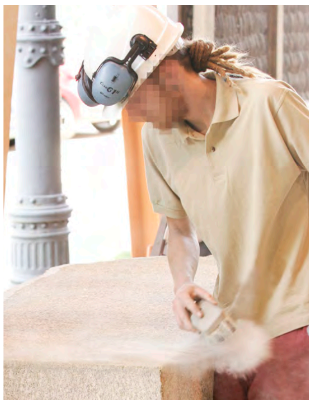
Colocación inadecuada de orejeras.
