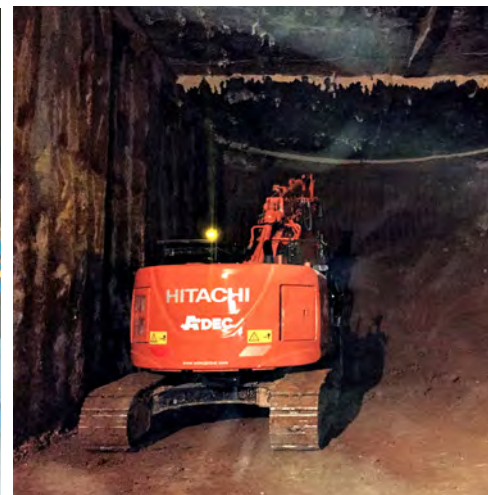
Excavadora giratoria sobre cadenas.
