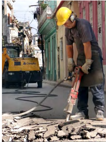
(derecha) Uso de martillo neumático (izquierda) Uso de equipos de corte.
