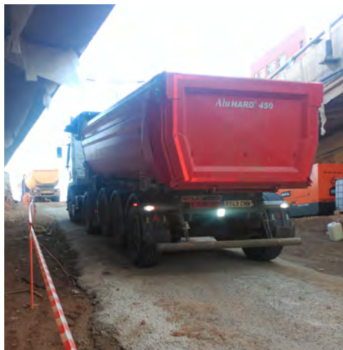
Movimiento de camiones.
