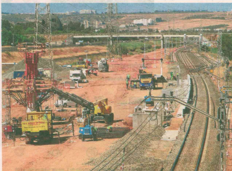
Obras en un trazado ferroviario de Cercanías. ROCÍO RUZ
