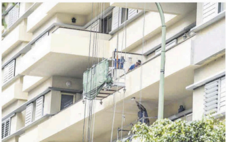
Obras de reforma en la calle Néstor de La Torre. JOSE CALVO/AGENCIA
