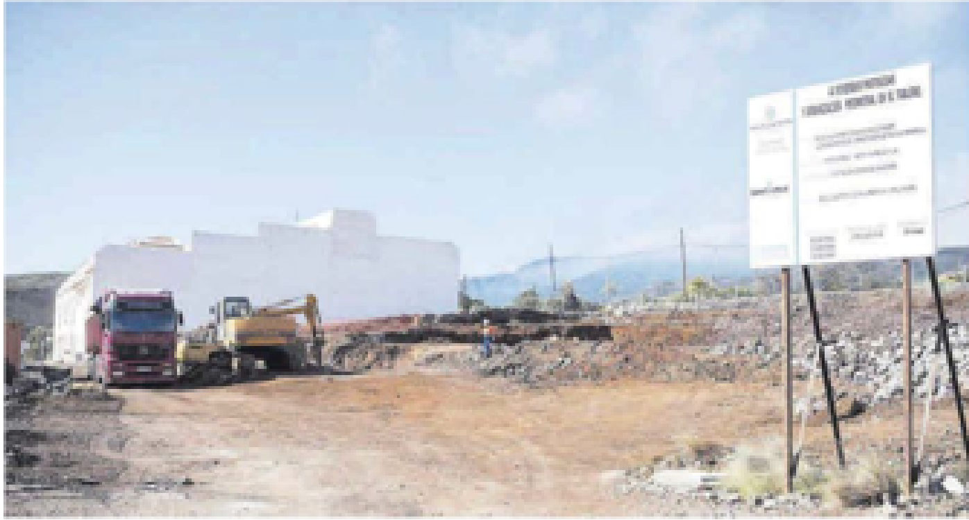
Un instante de los trabajos para la construcción de 44 viviendas protegidas en la localidad de El Tablero, en Santa Cruz de Tenerife.
