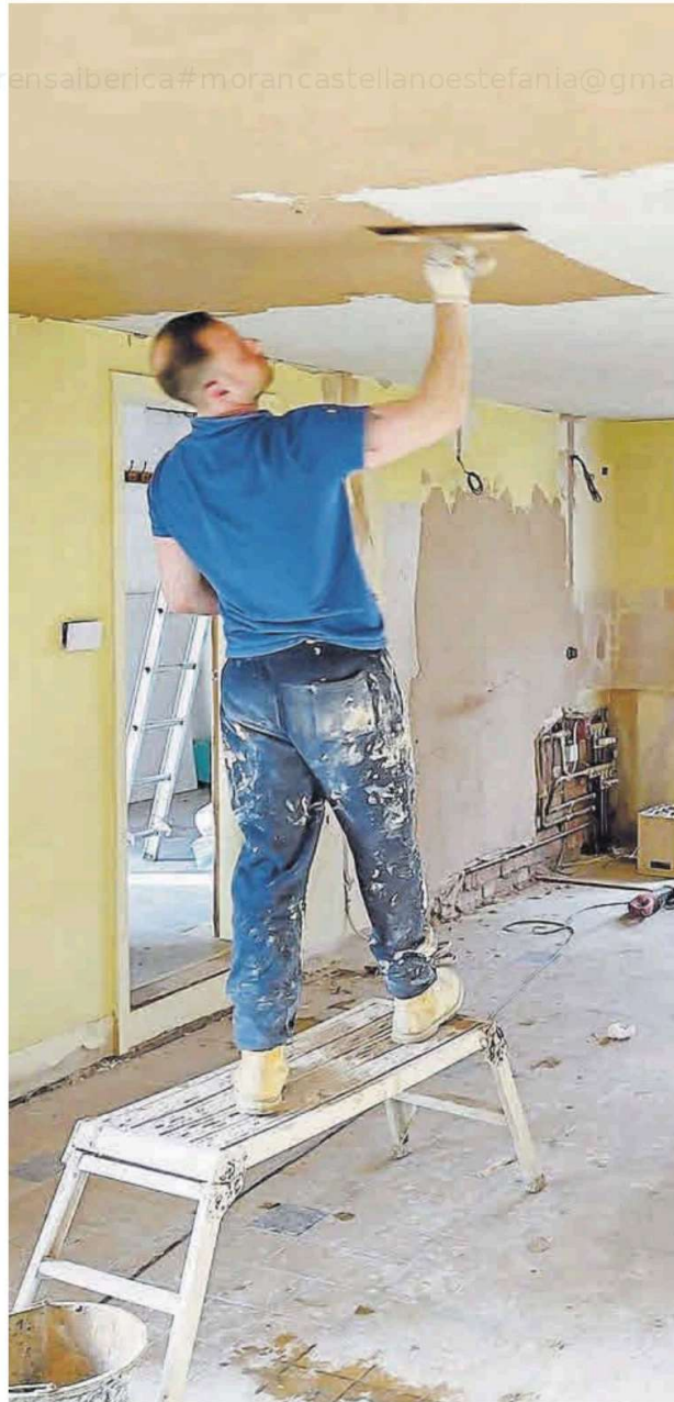
Un operario durante su jornada de trabajo en la reforma de una vivienda. | LP / DLP
