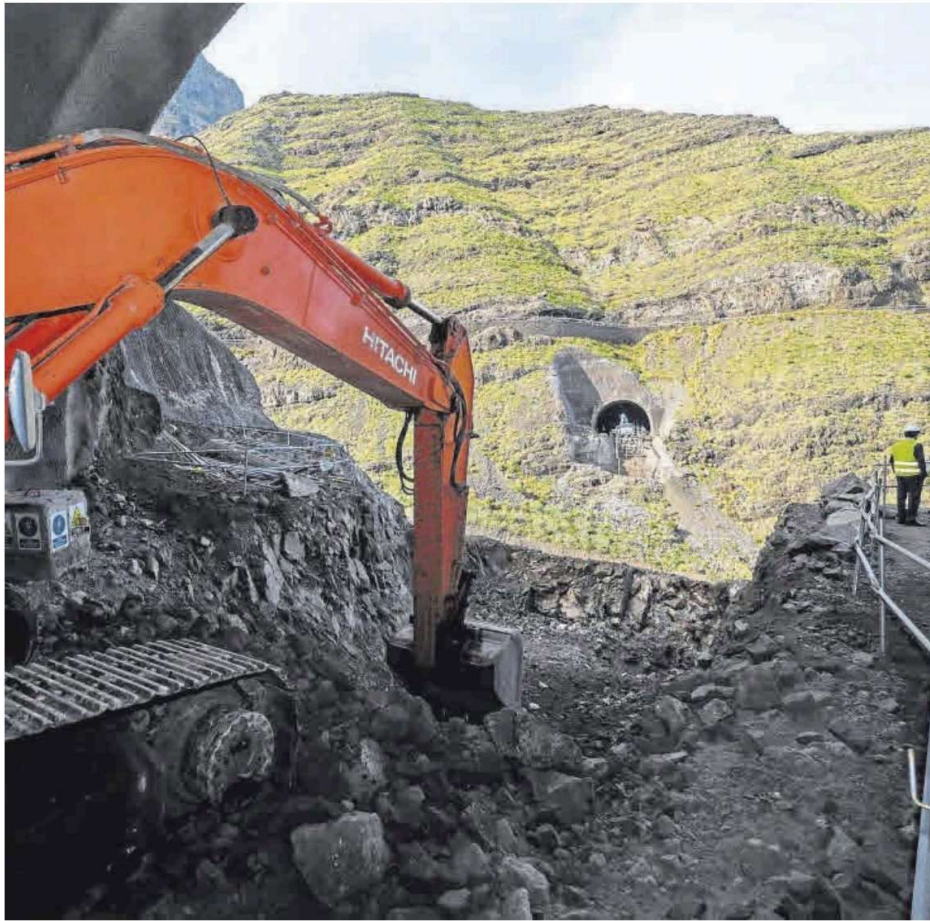
Trabajos en la carretera de La Aldea, en su segunda fase entre Agaete y El Risco. | Andrés Cruz
