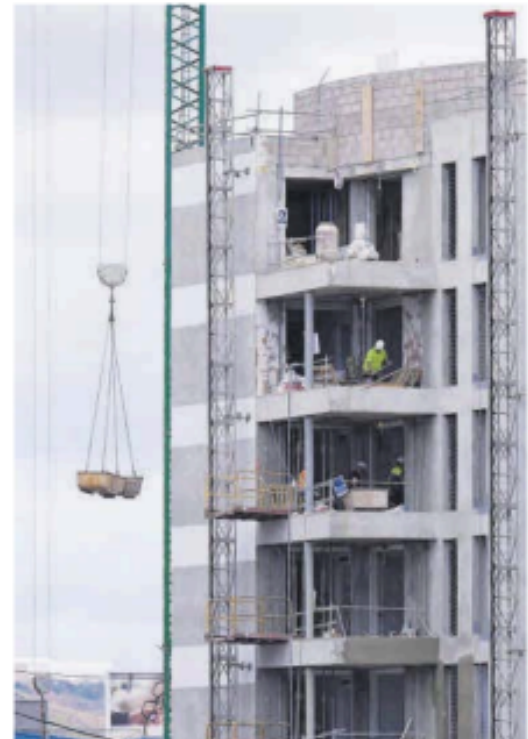
Obreros en la construcción de un edificio de viviendas.
